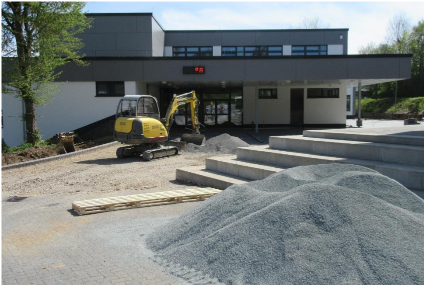
Foto: Energetisch saniertes Haus Bigge und Arbeiten auf dem Schulhof
