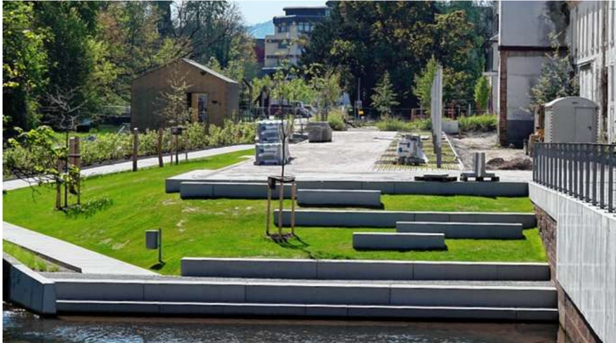
»Grüner Strand«: der neue Aufenthaltsort an der Wasserstraße. ©Stadt
