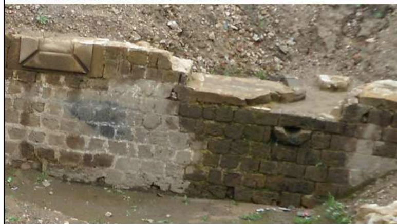
Foto Auslaufelement historische Mauer
