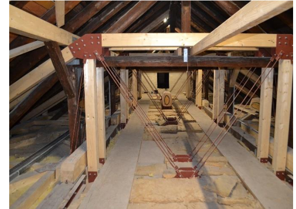
Umfangreicher Balkenaustausch im Dachbereich
