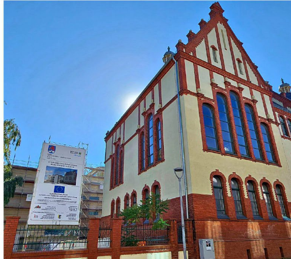
Die Baustelle des Schulcampus kann Anfang Mai besichtigt werden.
